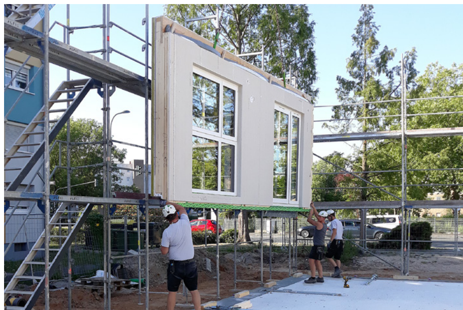
Abb. 1: Aufbau eines Hybridgebäudes mit Massivholzwänden und Betondecken beim Versetzen der Holzelemente
