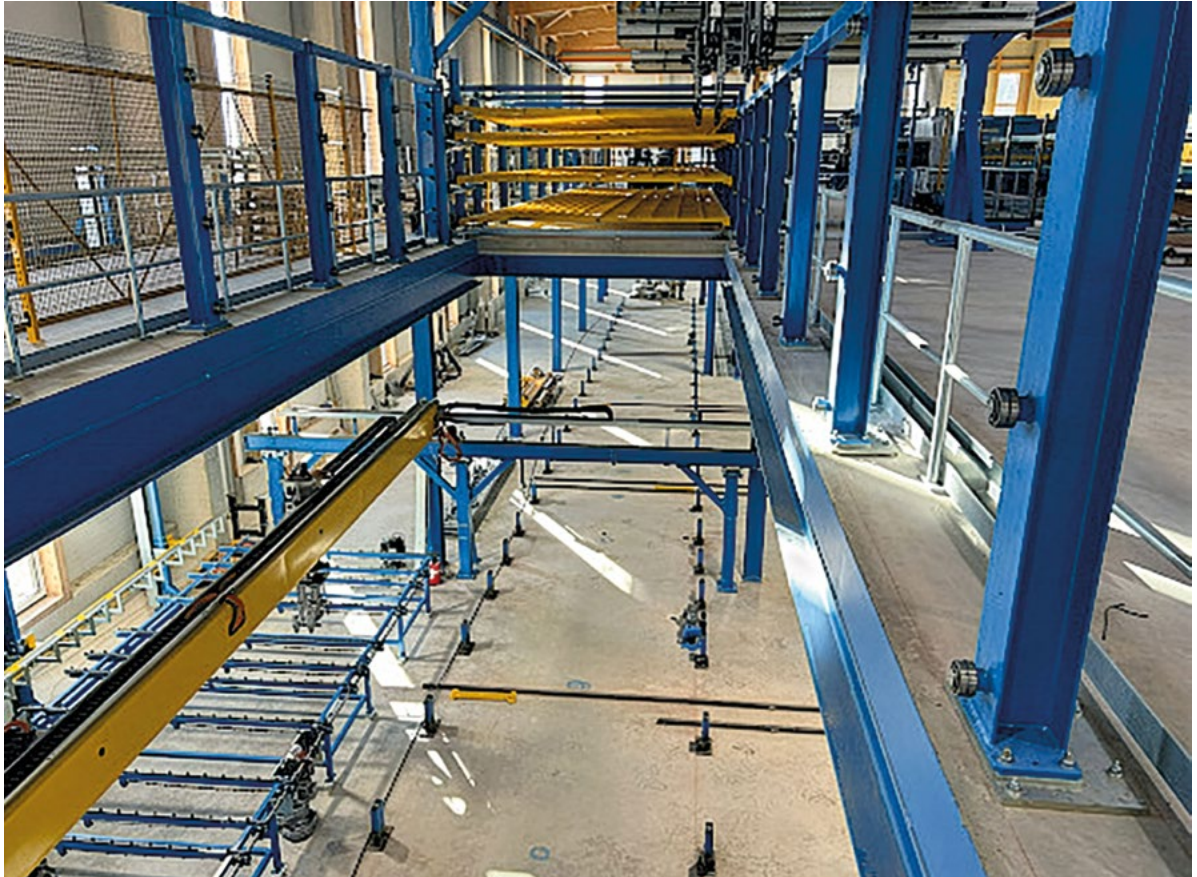
Hochmoderne Anlagen ermöglichen hohen Qualitätsstandard.
