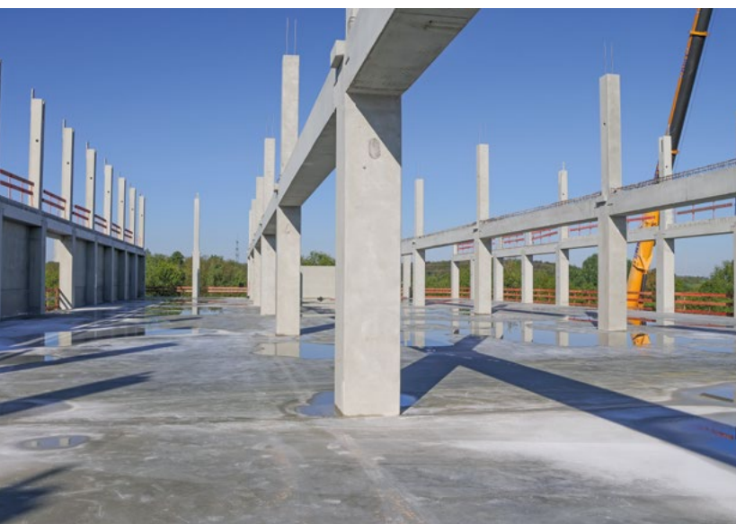
Wiederholung und serielle Vorfertigung im Gewerbebau.
