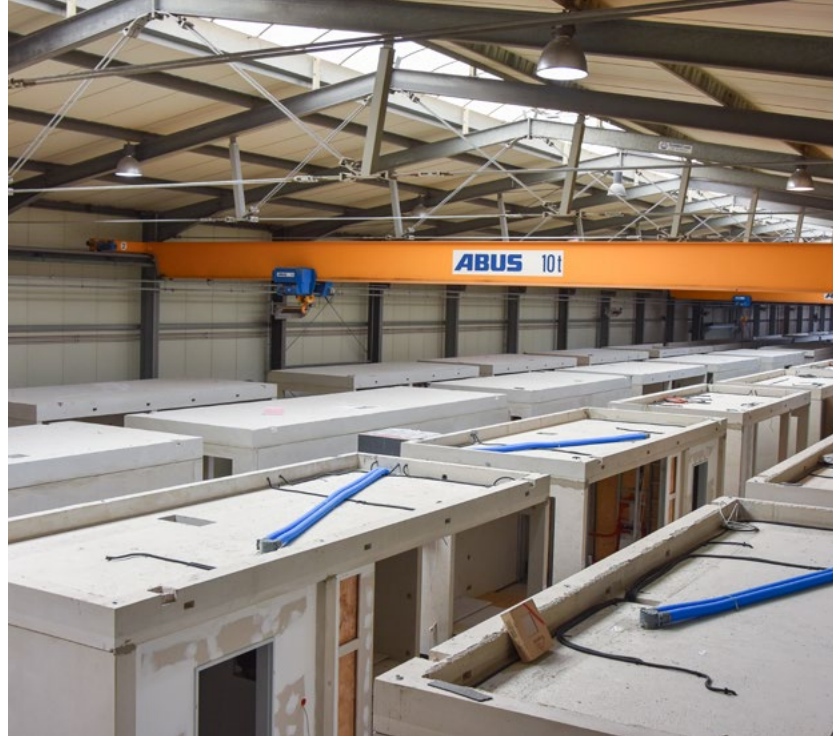
Seriell vorgefertigte Module im Werk.
