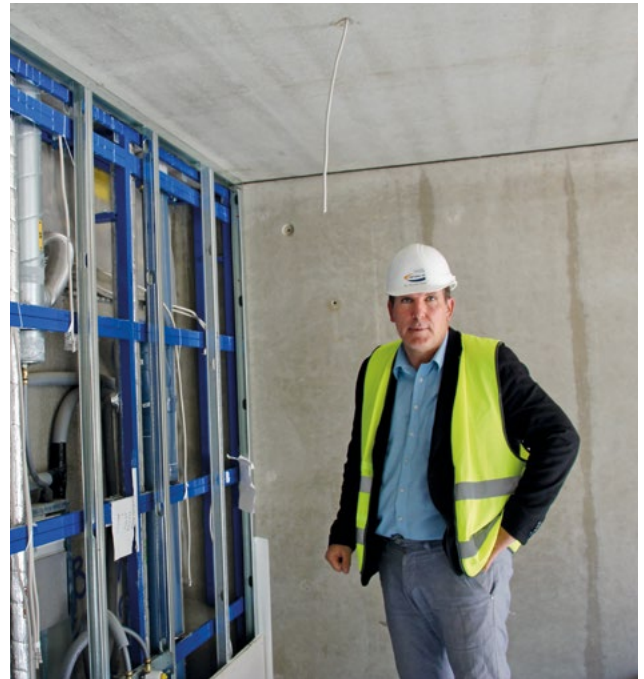
Henry Götze, Abteilungsleiter Technik der Wohnungsgenossenschaft „Carl Zeiss“ eG, auf der Baustelle.
