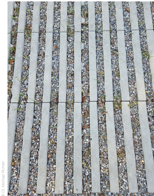
Versickerungsfähiger Belag mit Anpflanzung von Schotterrasen zur langfristigen Gewährleistung der Versickerungsfähigkeit.
