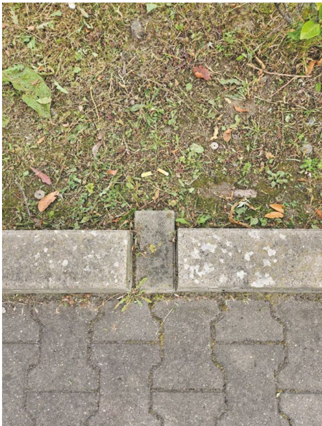
Einlaufbauteil (Betonpflasterstein) zwischen auf Lücke gesetzten Bordsteinen kann Überwuchs verhindern.
