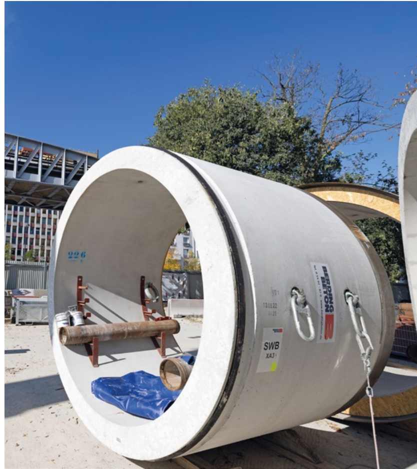
Insgesamt lieferte Berding Beton für die Baumaßnahme 315 Stahlbetonvortriebsrohre mit je 11 t Gewicht.
