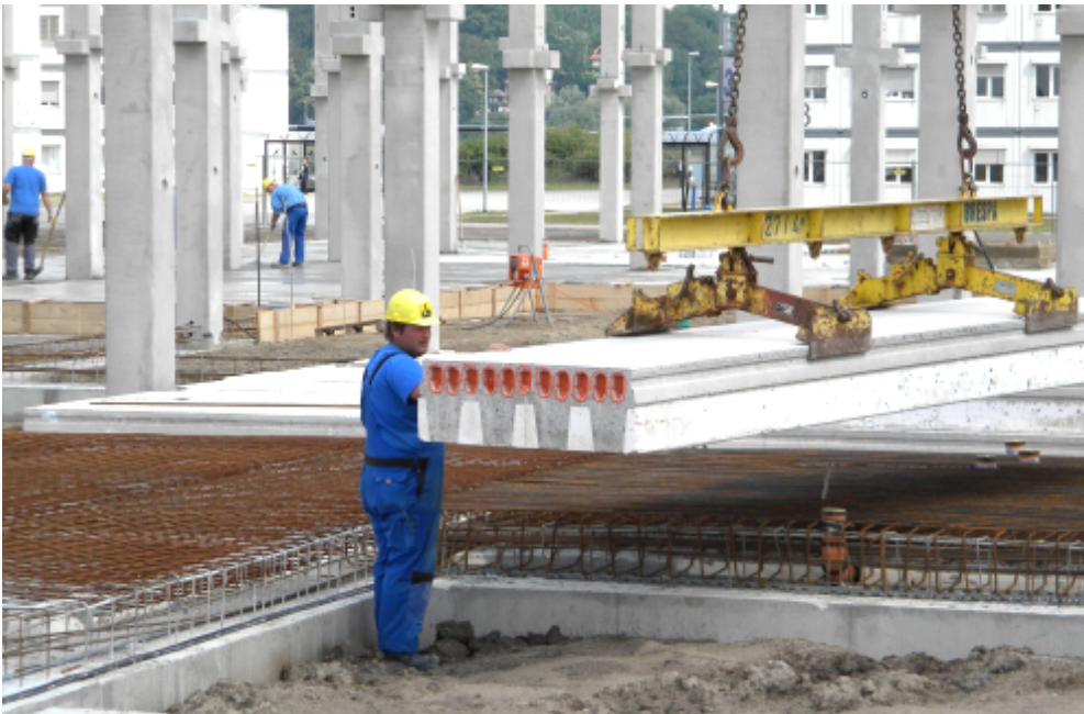
Iso-Platten mit 20 cm unterseitiger Dämmung
